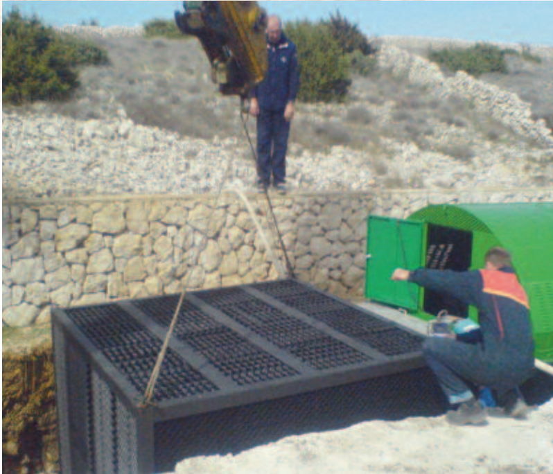
Ugradnja upojnih bioboxeva / Installation of absorption biobox
