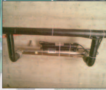
UV dezinfekcija / UV disinfection
