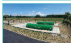
BIOREAKTORSKA POSTROJENJA BIOREACTOR PLANTS
