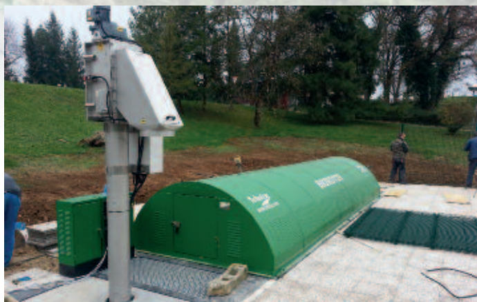
U sklopu kompleksa hotela u Sloveniji - sa automatskim izvlačaćem krutina Within the hotel complex in Slovenia - with automatic extraction of solids
